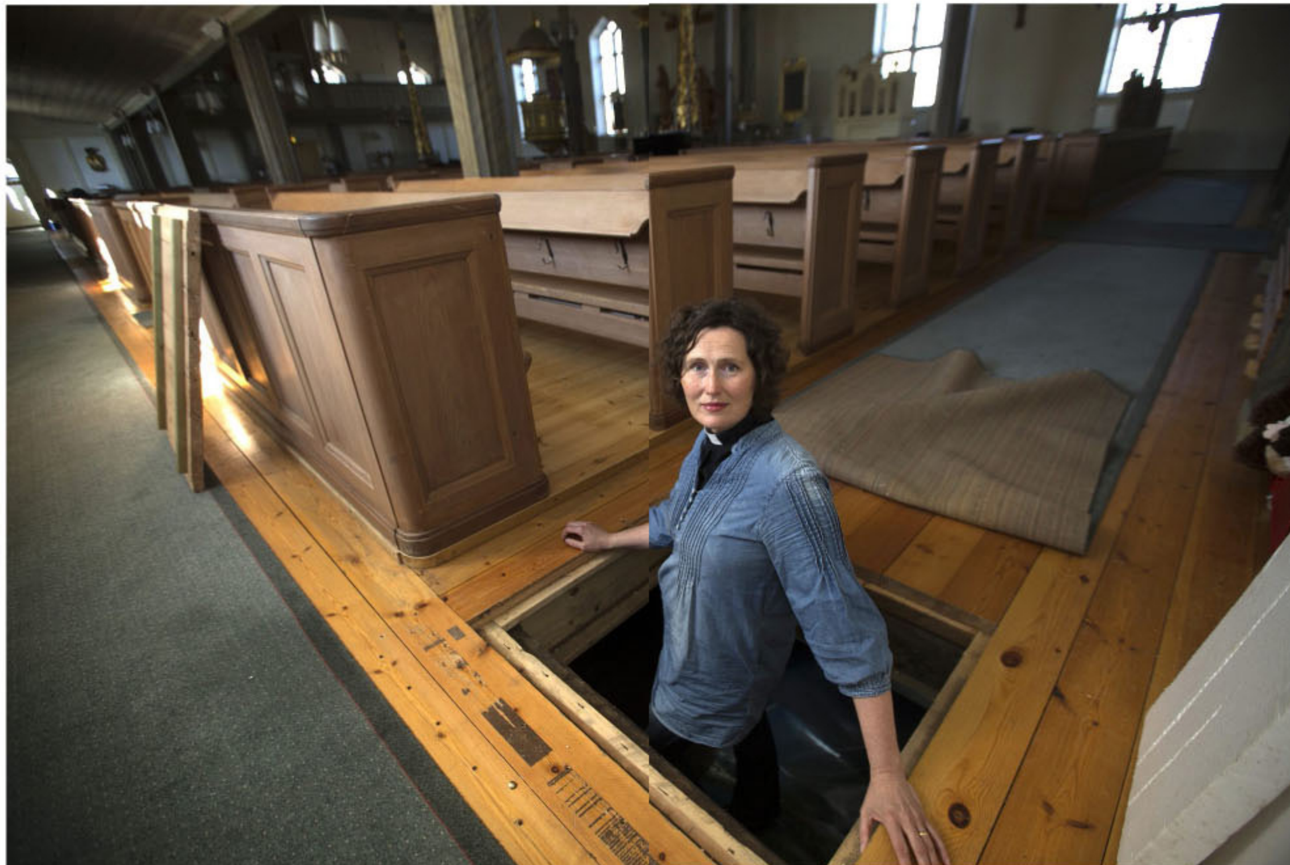
HAR LÅST PÅ. Under saneringen av Råneå kyrkas kryppgrund hittades bland annat en del bendelar och det fick den tillförordnade
